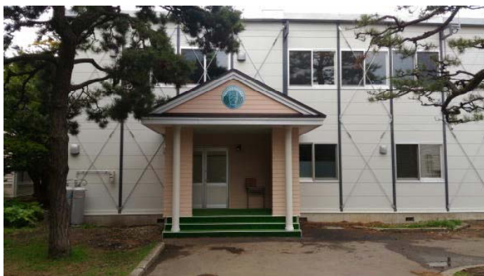
プレハブ管理棟の正面玄関が遺愛らしくなりました。
